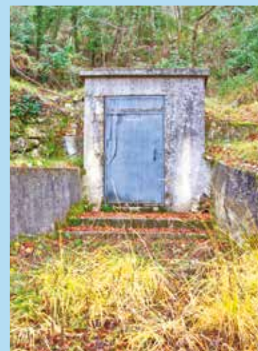
Captage de la source Constant (vue extérieure)
